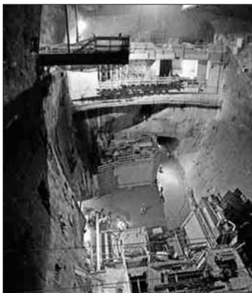
Beeindruckende Dimensionen im Bergmassiv: Baustelle einer Kraftwerkskaverne
